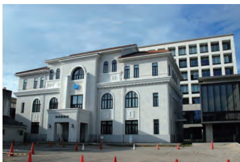
写真29 旧市庁舎の2階を、市議会議場として活用するとともに、1階と3階は「豊岡稽古堂」と命名し、市民の交流拠点とした。周辺にも昭和初期の鉄筋構造物が立ち並んでいる。
