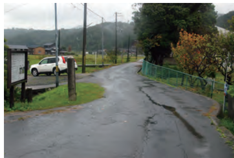
写真30 ただの曲がった道ではない。石柱の向こう側にある郷村断層が地震でずれて、道路や田んぼごと左側に移動したことが分かる説明看板も置かれている。
