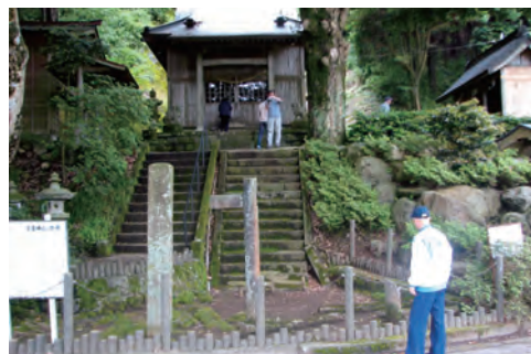
写真26 函南町の丹那盆地にある火雷神社。石段と鳥居の間に断層が通ったため、手前の鳥居が1mあまり、右にずれた。揺れで崩れた鳥居も、そのまま保存されている。
