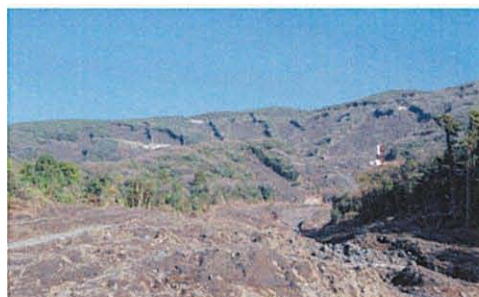
写真57 伊豆大島の神達地区から見上げると、豪雨で斜面が幅広く崩れたことが分かる。
