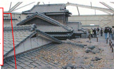
写真43 南島原市の土石流被災家屋保存公園では、普賢岳噴火に伴う土石流災害で被害に遭った家屋10棟を、3mほど土砂に埋まった当時のままで保存し、1棟を移築して、展示している。
