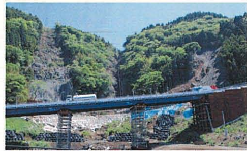
写真59 九州北部豪雨で崩れた崖を登る国道にかけられた阿蘇市の仮設橋。
